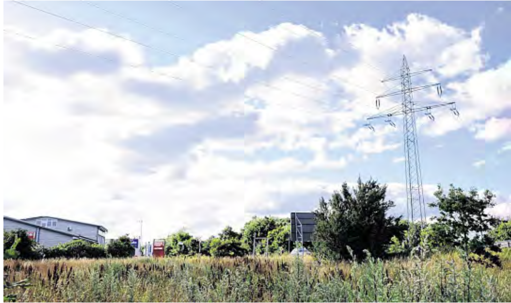
Tiefhängende Stromleitungen im Erweiterungsbereich für das Gewerbegebiet „Heideland“ bereiten den Gemeindevertretern Probleme. KIRSCHNER
